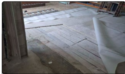
Wymiana paneli podłogowych w parciackiej szkole
