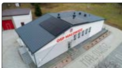
OSP Małowidz z nowo zamontowanymi panelami fotowoltaicznymi i magazynem energii
