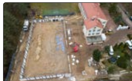
Budowa hali sportowej przy szkole w Parciakach
