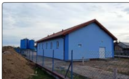
Zmodernizowana hydroforna wraz z dodatkową studnią w Jednoróżcu
