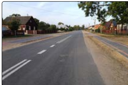
Odnowiona droga gminna w Olszewce
