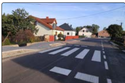
Modernizacja drogi w Ulatowie-Pogorzeli
