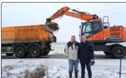
Przebudowa drogi gminnej do Ulatowa-Ślabogóry
