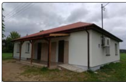
Remiza wiejska w Obórkach, nowa elewacja.
