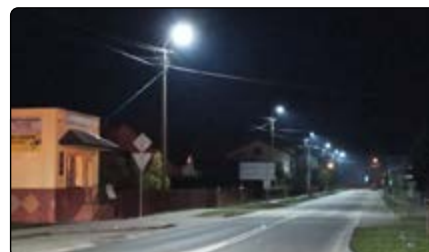
Wymiana oświetlenia ulicznego na energooszczędne
