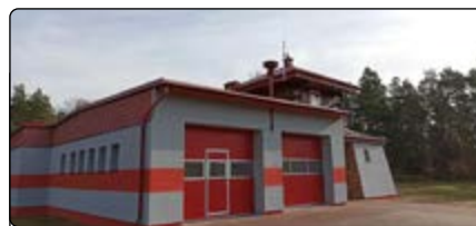
Nowa elewacja remizy OSP w Parciakach
