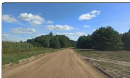
Droga transportu rolnego Jednoróżec-Ste-gna-Drąždżewo Nowe
