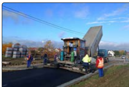
Budowa ul. Kazimierza Wielkiego w Stegnie
