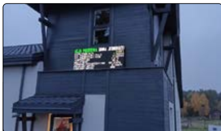
Przebudowana remiza ze stacją pogodową w Żelaznej Rządowej
