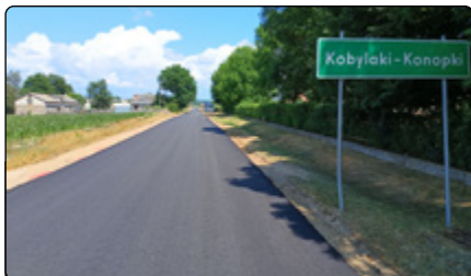
Nowa droga w Kobylakach Konopkach
