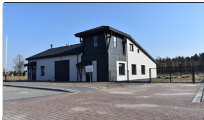
Nowy podjazd przed remizą OSP w Żelaznej Rządowej
