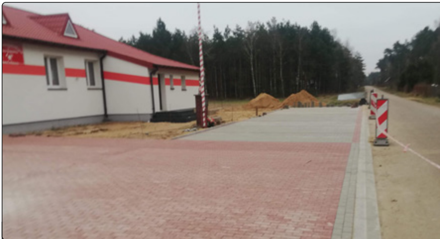
Zatoka postojowa przy remizie w Budach Rządowych
