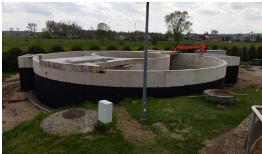
Rozbudowa oczyszczalni ścieków w Jednorozcu
