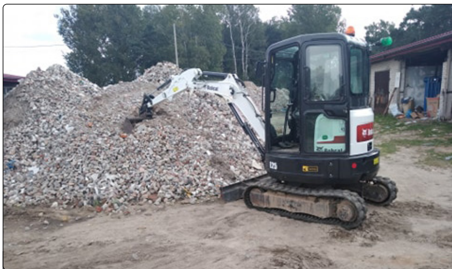
Rozdrobnienie odpadów wielkogabarytowych i gruzu
