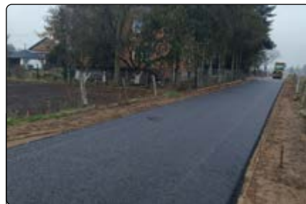
Przebudowa drogi gminnej w Ulatowie-Pogorzelskim
