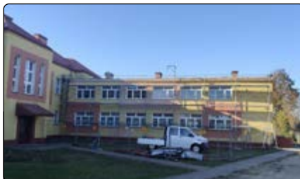
Wymiana pokrycia dachowego w Szkole Podstawowej w Olszewce
