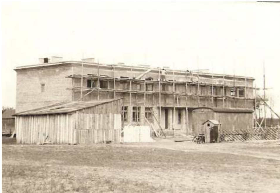
Budowa nowej szkoły w Lipie.
