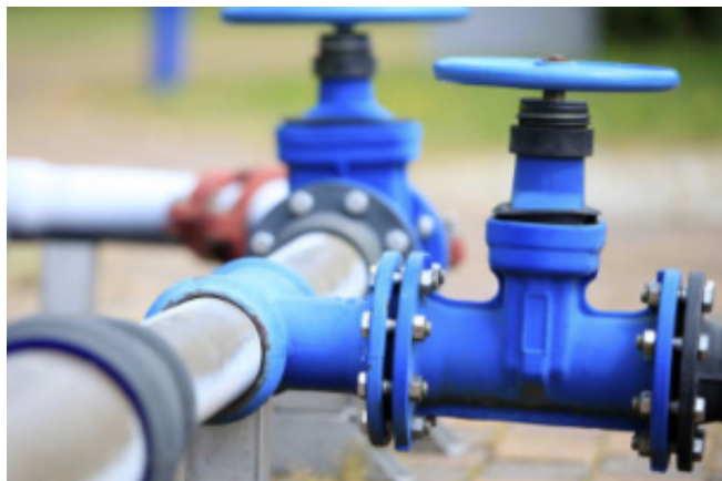
Kluczową inwestycją w 2018 r. będzie budowa sieci wodociągowej do Lipy oraz kanalizacji sanitarnej do Drażdźewa Nowego
