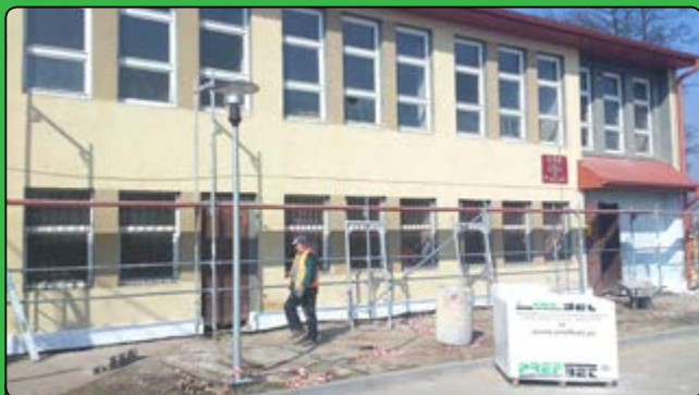
Rozpoczął się remont remizy OSP w Połoni
