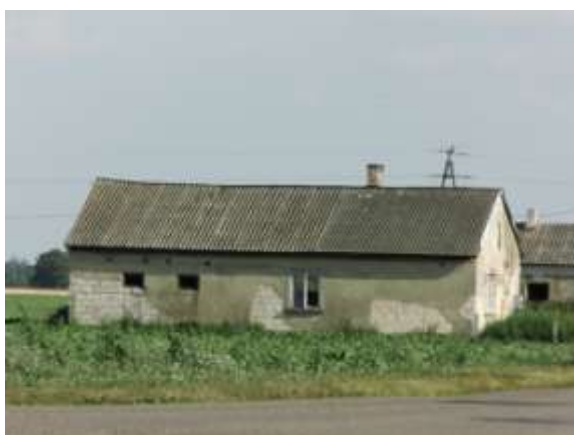
Rys. 2. Pokrycia dachowe zawierające azbest: płyty faliste (po lewej) oraz płaskie (po prawej). (źródło: materiały własne)
