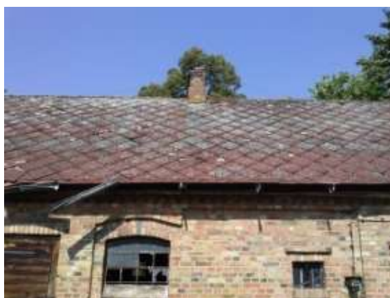
Rys. 2. Pokrycia dachowe zawierające azbest: płyty faliste (po lewej) oraz płaskie (po prawej). (źródło: materiały własne)
