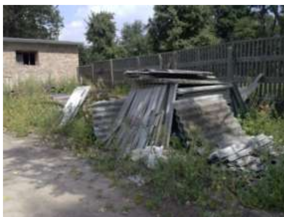
Rys. 3. Odpady zawierające azbest – zmagazynowane płyty faliste. (źródło: materiały własne)
